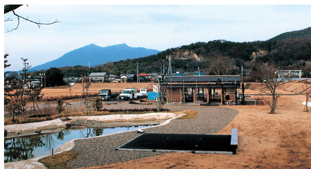
筑波山（左奥）と建設中のあずま屋
